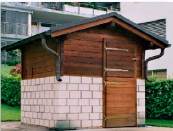
Hütte über Bohrloch
