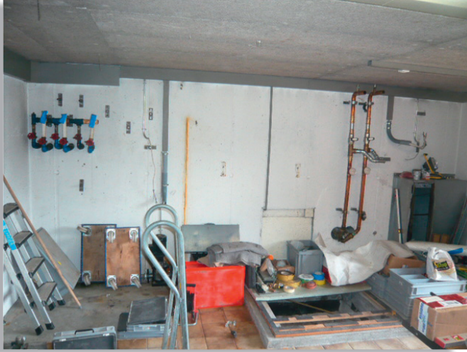
Heizraum VOR der Sanierung
